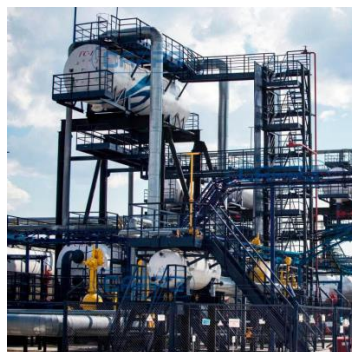
Рисунок 3 – установка дополнительного оборудования
